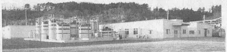
いわき工場の排水設備
